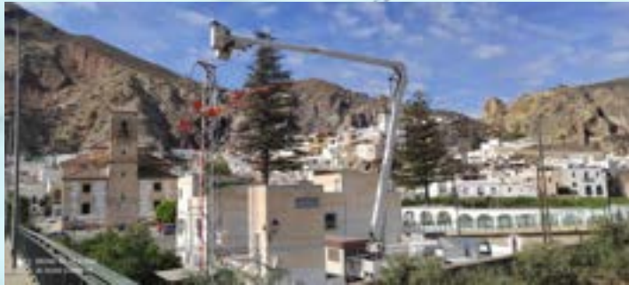
MEJORAS EN TRANSFORMADOR
