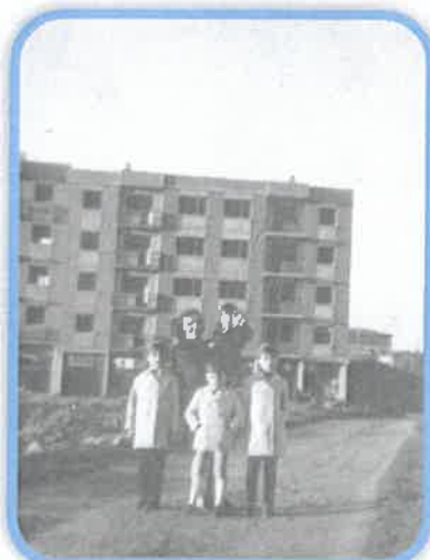
1968. Cooperativa San Isidro en obras
